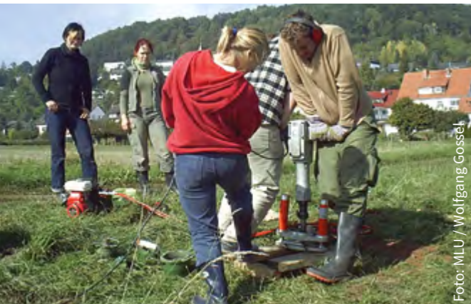
Eine Grundwassermessstelle wird gebaut.
